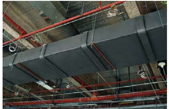
Zur Dämmung der Luftkanäle wurden Class 0 Armaflex Platten verwendet
