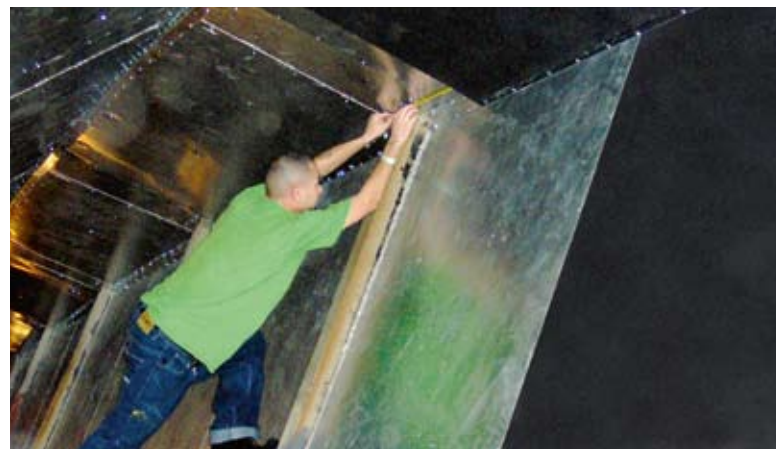
Die riesigen Luftkanäle wurden mit AP Armaflex gedämmt und sind so sicher vor Tauwasser geschützt
