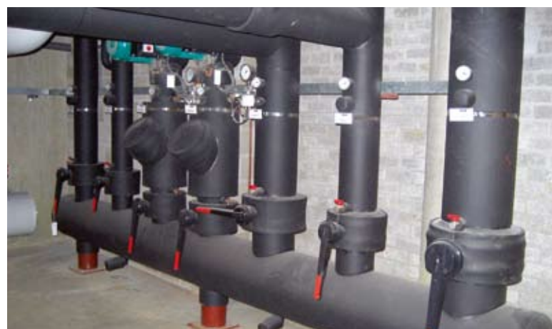
Kältetechnische Anlagenteile sind mit AF/Armaflex sicher vor Energieverlusten geschützt
